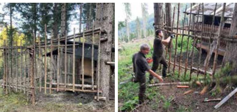
Ausbesserungsarbeiten und Sanierung von Futterstellen (Fotos: Thomas Geiler)
