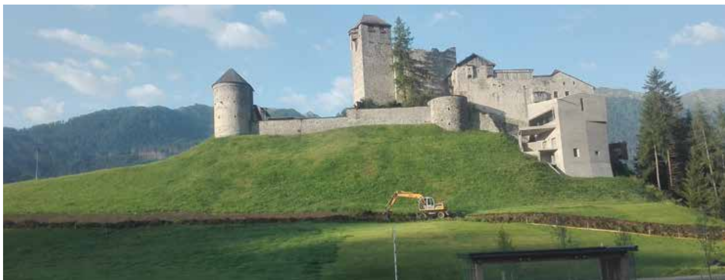
Anlage des Gehwegs bei der Burg Heinfels
