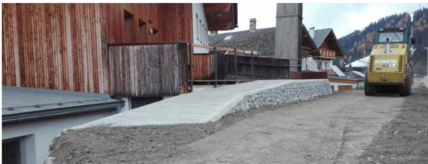
Errichtung einer Rampe beim Vereinshaus in Panzendorf
