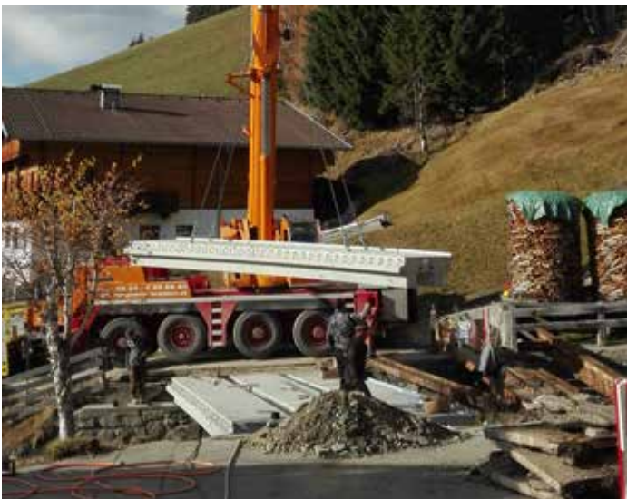
Austausch der oberen Brücke beim Tessenberger Bach (Errichtung einer Betonbrücke)
