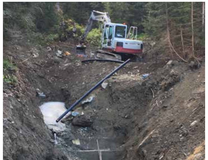
Sanierung der Quellfassung
