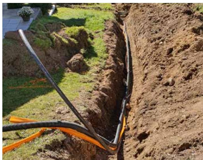
Grabungsarbeiten für das LWL-Netz in Heinfelsberg und Tessenberg-Oberberg
