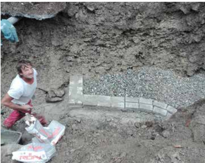
Sanierung der Quellfassung
