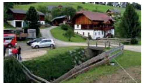
Neuer Löschwasserbehälter bei Fam. Hangler.
