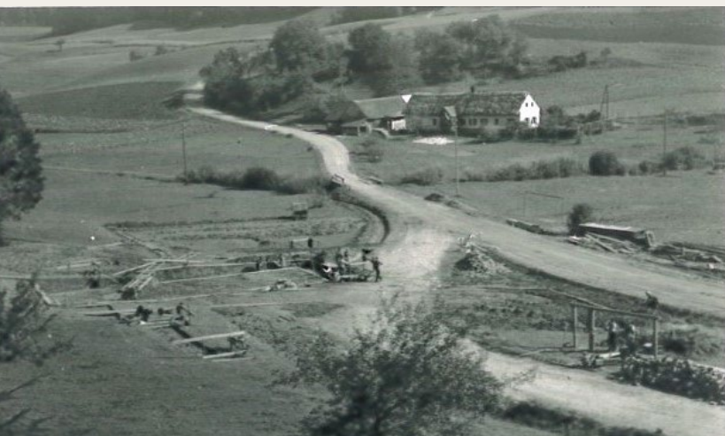
Nov. 1954, "Eiriegel" im Hintergrund links vorne erste Arbeiten beim Volksschulbau.
