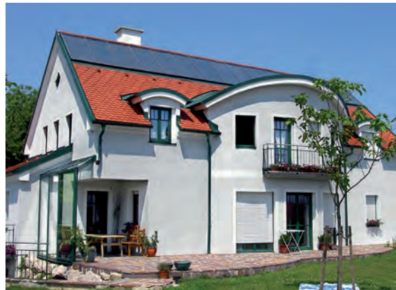
Hausfoto mit Solaranlage
