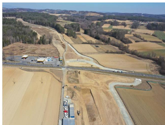
Baustellenüberblick UFT / B65
