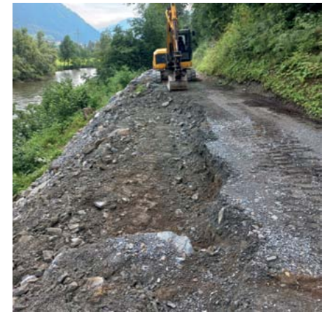
Viele Niederschläge erforderten eine weitere Sanierung des Murwaldweges.
