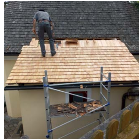
Dachsanierung Aufbahnhalle St. Lorenzen
