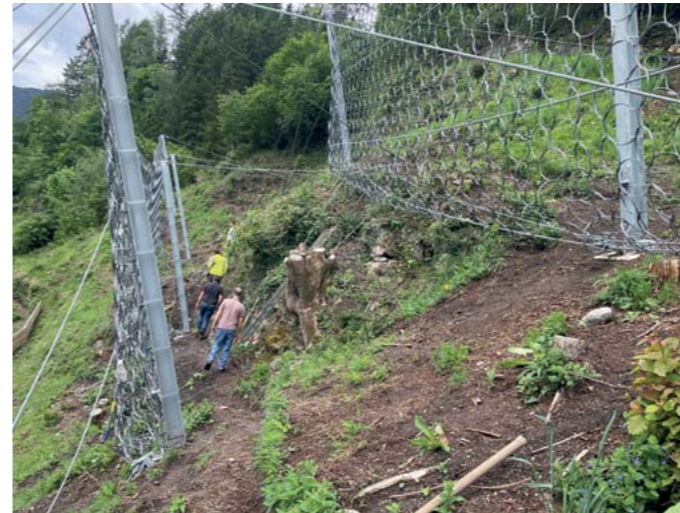
Steinschlagschutz in Lind
