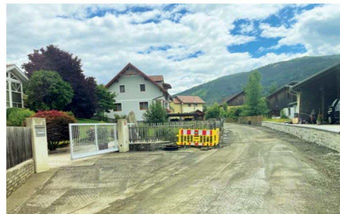
Straßensanierung nach Erneuerung der Wasserleitung Höhenweg
