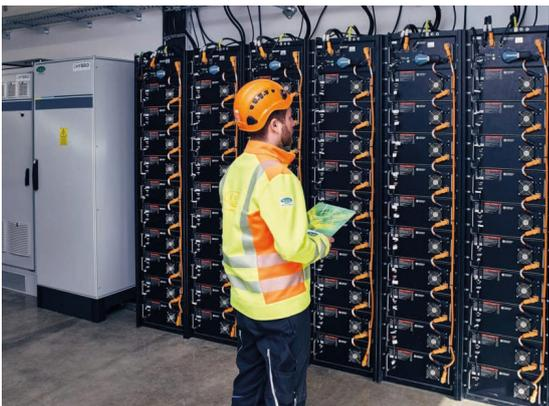
Der Batteriespeicher verfügt über eine Kapazität von 550 kWh. (Bilder: KEM Montage GmbH)
