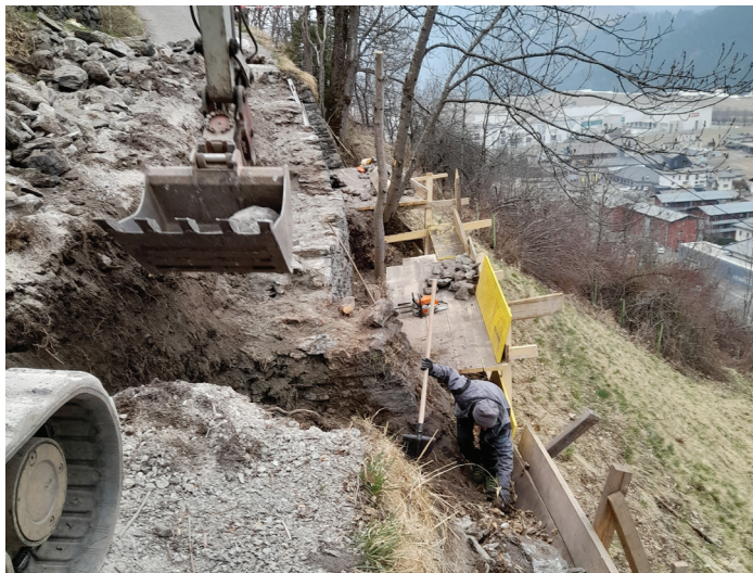
Sanierungsarbeiten beim Burgweg - Abbruch ...
