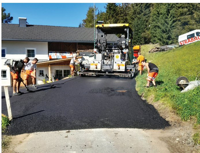
Asphaltierungsarbeiten im Tessenberger Oberberg
