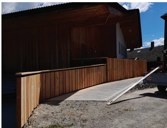
Fertigstellung der Rampe beim Vereinshaus in Panzendorf
