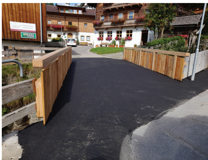
Sanierung der unteren Brücke beim Tessenberger Bach
