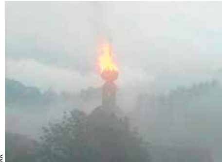
Der brennende Kirchturm der Filialkirche St. Blasen.
