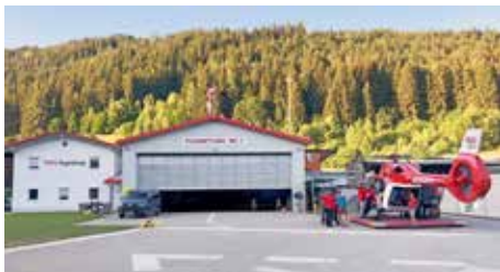
ARA Stützpunkt in Fresach.
