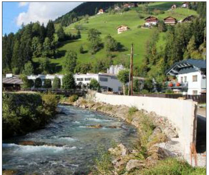
Verbauung Villgratenbach im Bereich Schloßmühle
