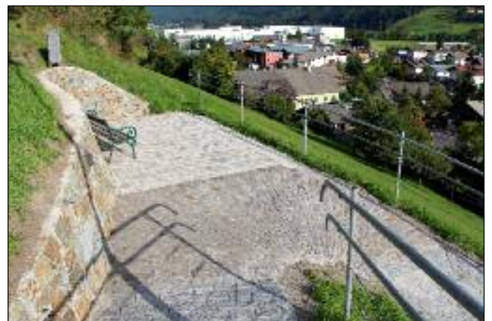
Neugestaltung Franz-Kofler-Weg: Mauer und Pflasterarbeiten im Bereich der Kehre
