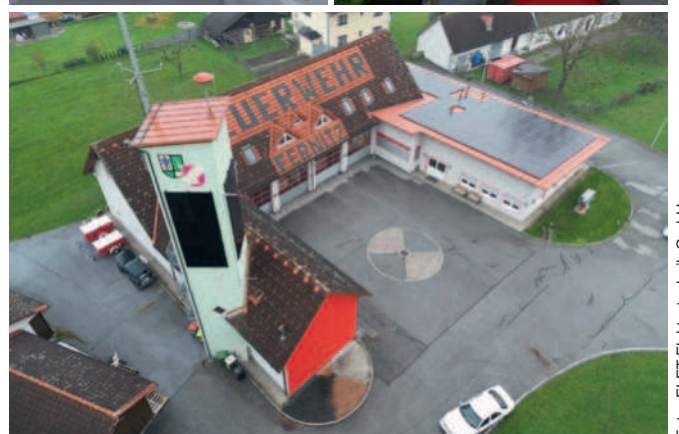
Foto: ELET Elektrotechnik GmbH
