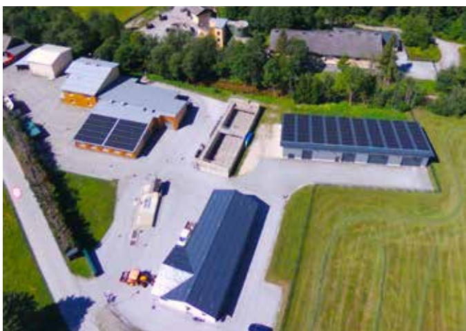
Die PV-Anlagen bei der Kläranlage.
