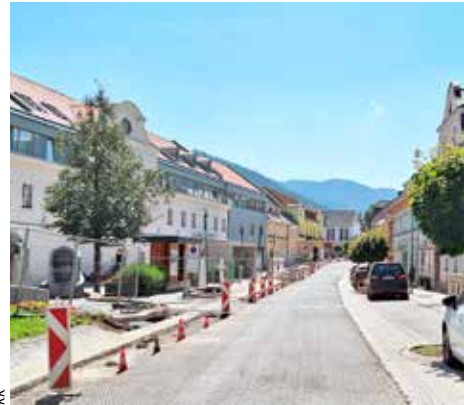
Die neue Ortsdurchfahrt soll bis Ende Oktober fertiggestellt sein.
