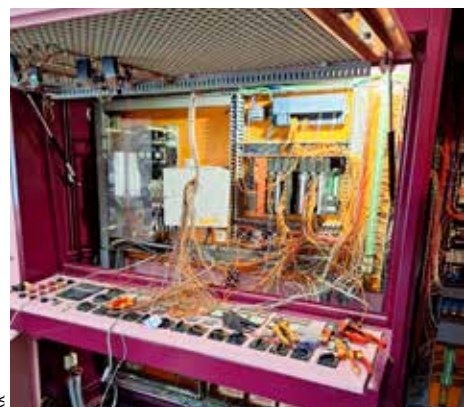
Alles neu in der Kläranlage St. Lambrecht
