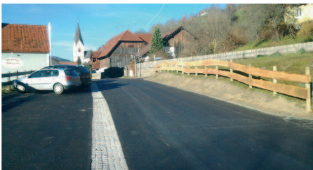
Sanierung Dorfstraße St. Georgen
