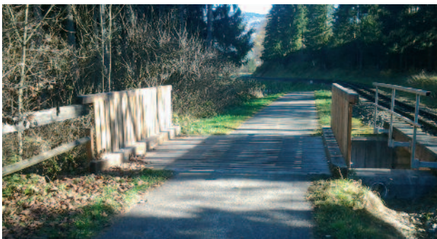
Sanierung Brücke Radweg Kaindorf
