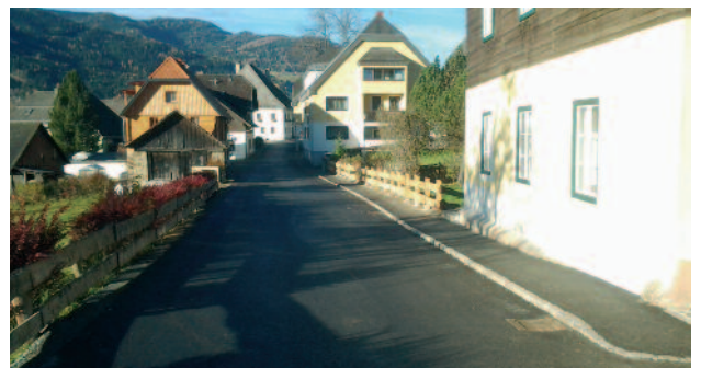
Sanierung Dorfstraße St. Georgen
