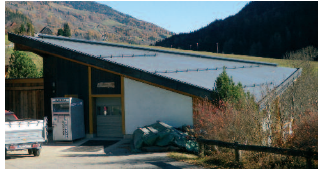
Neues Dach Kläranlage St. Ruprecht
