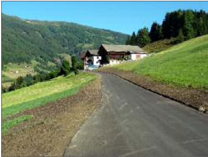
Fertigstellung der Straße bei den Rieserhöfen
