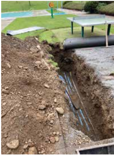
Leitungsschaden und Erneuerung Beckenrand im Freibad
