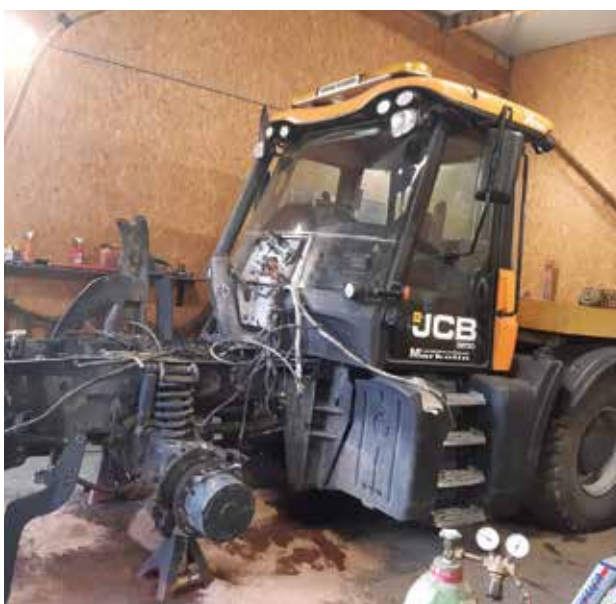
Reparatur Fastrac Erneuerung Kupplung
