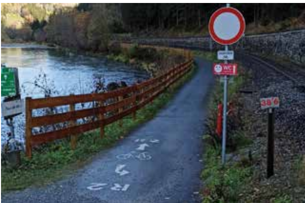
Verbesserungsarbeiten am Radweg
