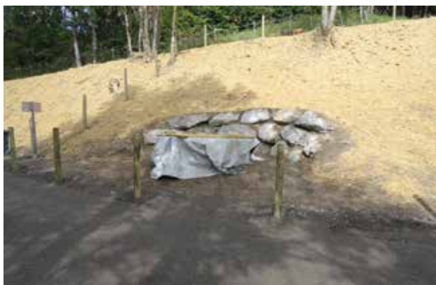
Sanierung der Quellfassung
