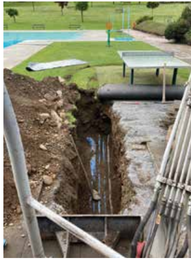
Leitungsschaden und Erneuerung Beckenrand im Freibad
