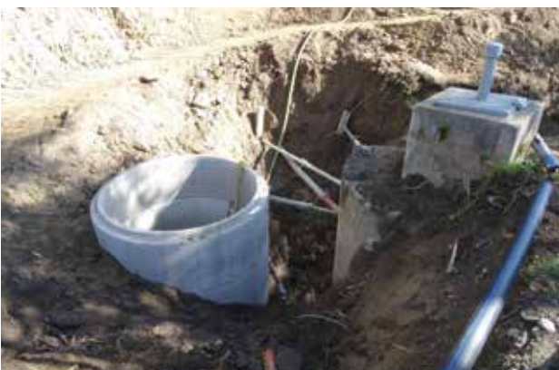
St. Ruprecht, Sanierung der Quellfassung
