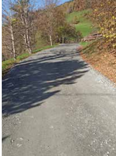
Grader- und Walzarbeiten Bereich vlg Simabauer
