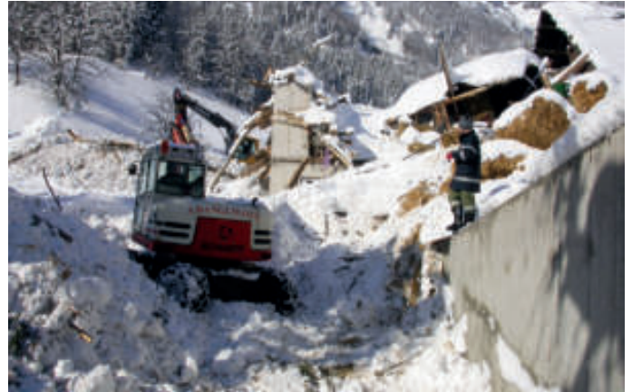
Freilegen des verschütteten Wirtschaftsgebäudes
