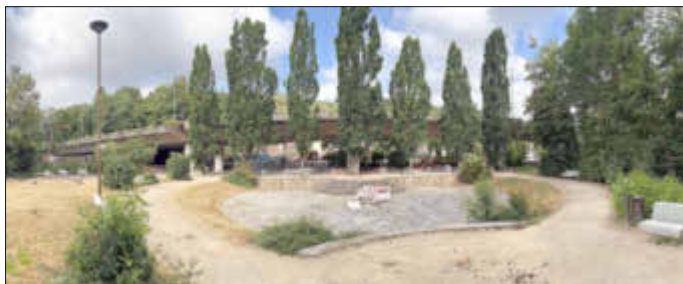
Der Helmut-Kohl-Europaplatz wird ab sofort klimagerecht umgestaltet. Die Arbeiten beginnen im Bereich des Idarbaches (rechter Bildrand), der Spielplatz (linker Bildrand) kann zunächst noch genutzt werden. Foto: Stadtverwaltung Idar-Oberstein
