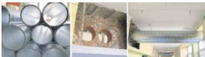
*Große gedämmte Lüftungsrohre führen zukünftig – wie hier in der GS Idar – in jeden Klassenraum. Dafür müssen zahlreiche Kernbohrungen vorgenommen werden. Die Rohre werden anschließend noch mit einer Brandschutzverkleidung ummantelt. (Fotos: Stadtverwaltung Idar-Oberstein)*
