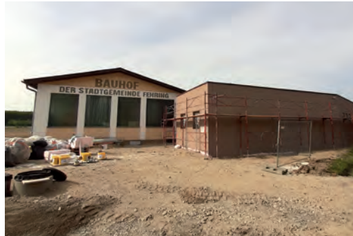
Bestehender Bauhof mit Zubau Mannschaftsgebäude Fotos: Stadtgemeinde Fehring
