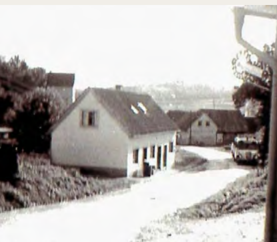
Das neue "Brennerei"gebäude an dessen Stelle.
