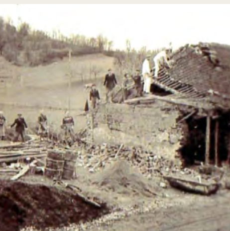
Abrissarbeiten beim alten Gebäude.
