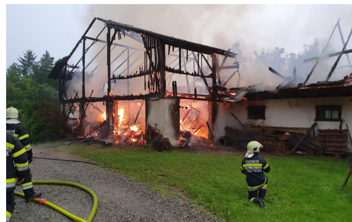
Wirtschaftsgebäudebrand in Nestelberg
