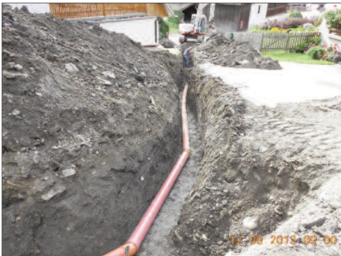
Herstellung von Kanalanschlüssen
