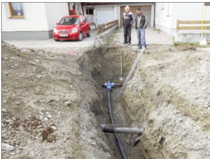
Wasserleitungsquerung bei Kosian Reinhold
