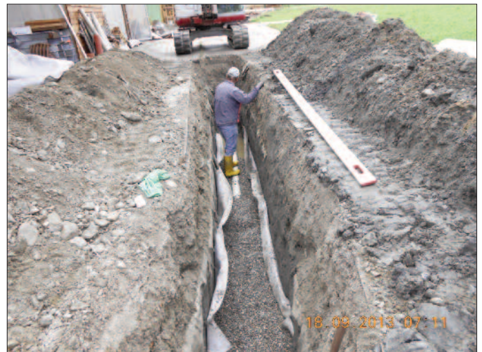
Herstellung von Kanalanschlüssen
