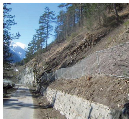
Steinschlag Untertösens Schutzzaun
