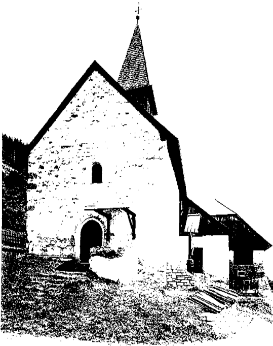
Filialkirche St. Bartholomäus in der Feßnach, Westfassade – 1969
