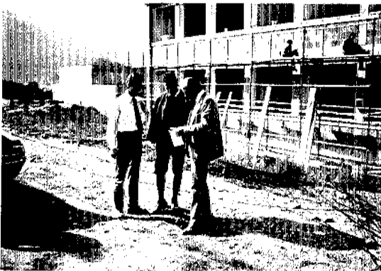
Rohbau der Hauptschule Scheiffling – März 1977. Im Vordergrund Bürgermeister Dr. Harald Schaunig, Architekt Dipl.-Ing. Kapfenberger und HS-Direktor Kurt Strohmeier
