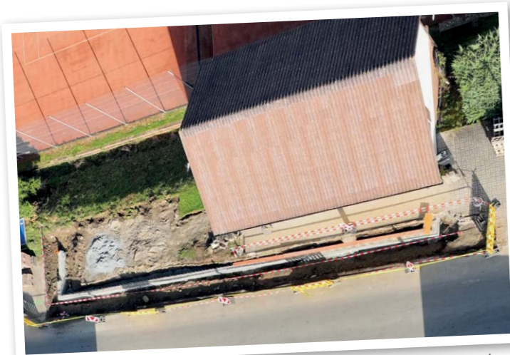
Luftaufnahme der Baustelle Zaunbau und Generalsanierung der Sitzterrasse
