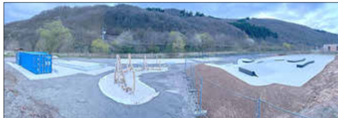
Die Panoramaaufnahme der – fast fertigen – Anlage lässt die vielfältigen Nutzungsmöglichkeiten erahnen. Foto: Stadtverwaltung Idar-Oberstein
