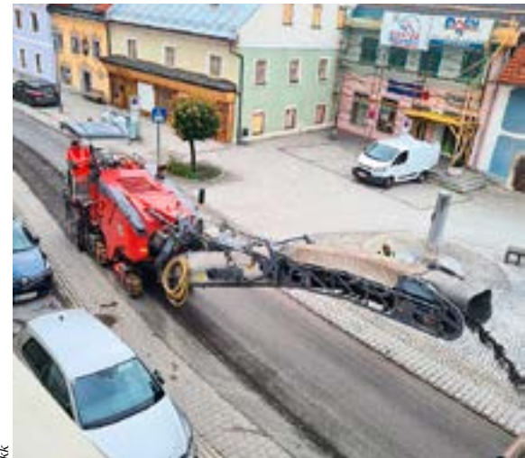
Die Ortsdurchfahrt wurde mit großem Gerät generalsaniert.
