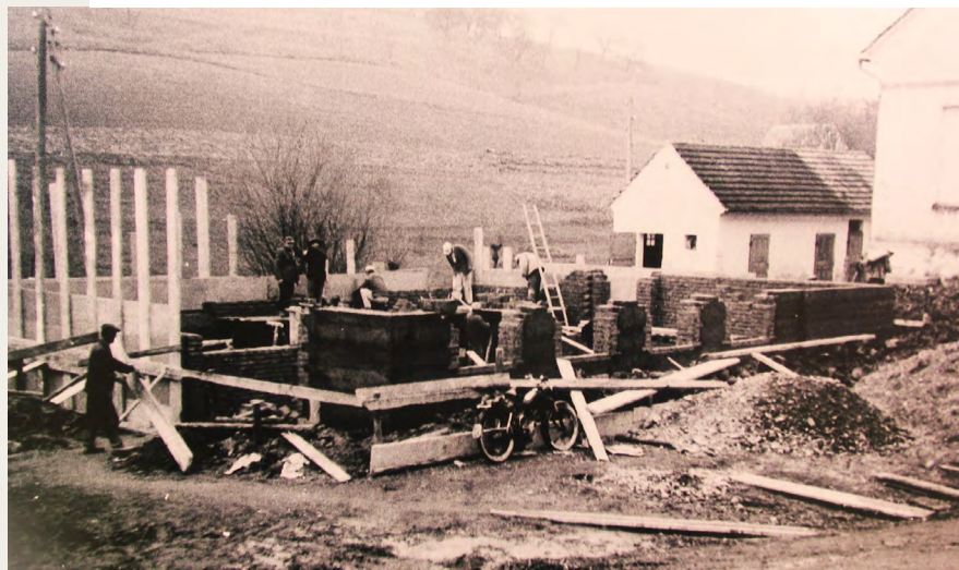
Baustelle Kalcher Lehrerwohnhaus
