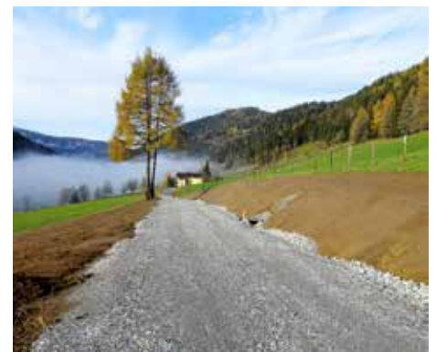
Die Sanierung Talweg wurde begonnen: Umfahrung Gruber vlg. Heining.
