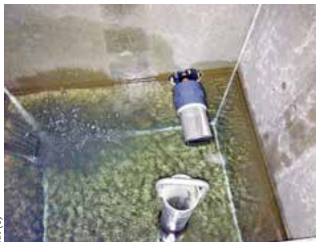
Sanierung von Sammelschächten im Bereich Schwarzenbach.
