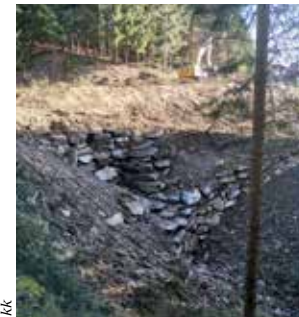
Neuer Wasserdurchlass inklusive Steinerschichtung am Spitalberg.
