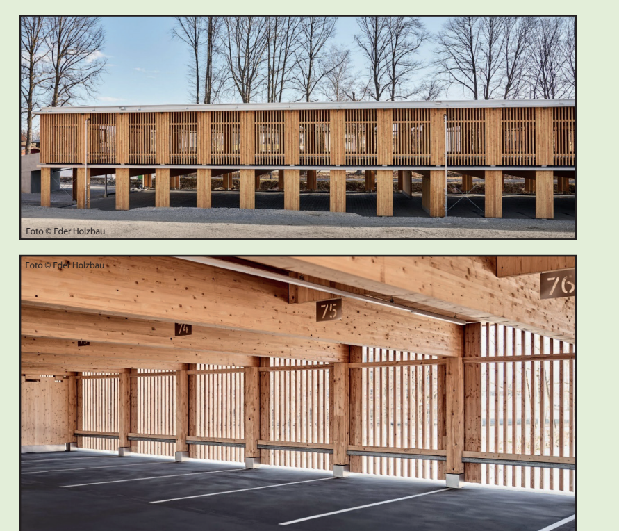
Beispiel Parkdeck Bad Aibling
