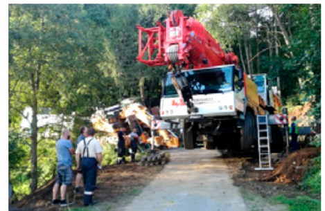
LKW und Baggerbergung am Freiberg
