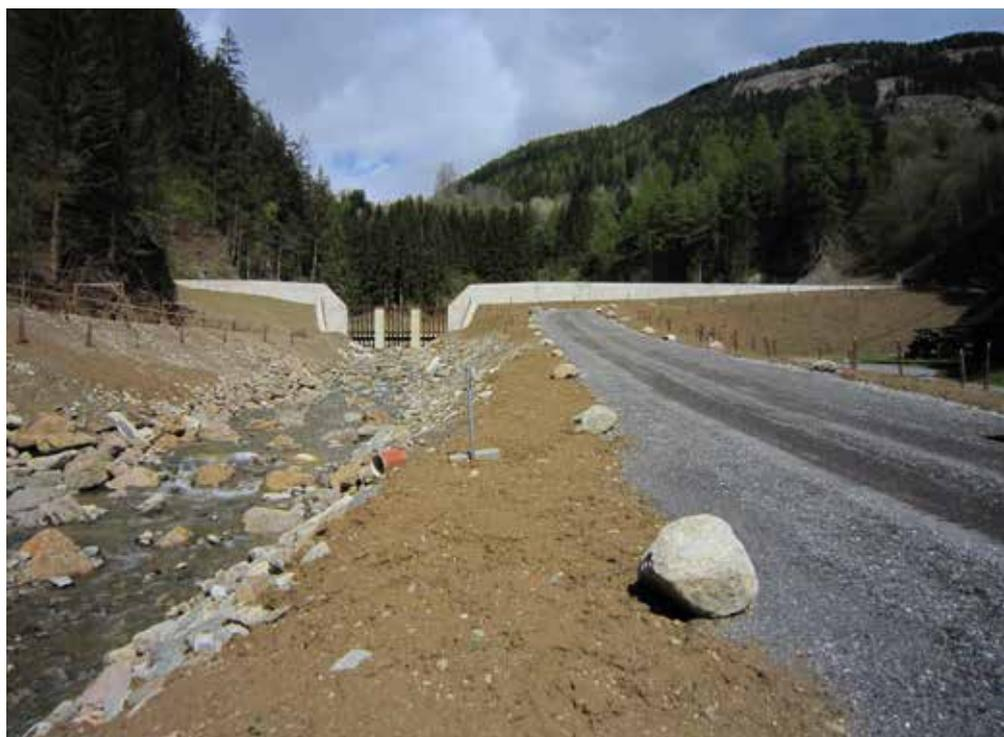
Foto 3: Geschiebesperre am Grabenausgang
