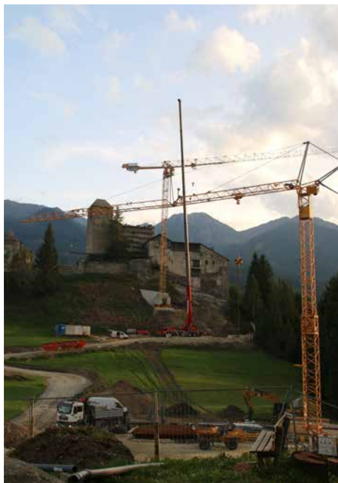
Ende August wurde mit der Großbaustelle nördlich der Burg begonnen. Hier entstehen Lager, die „Talstation“ der Materialseilbahn, Besucherparkplatz und der neue Küchenturm.
