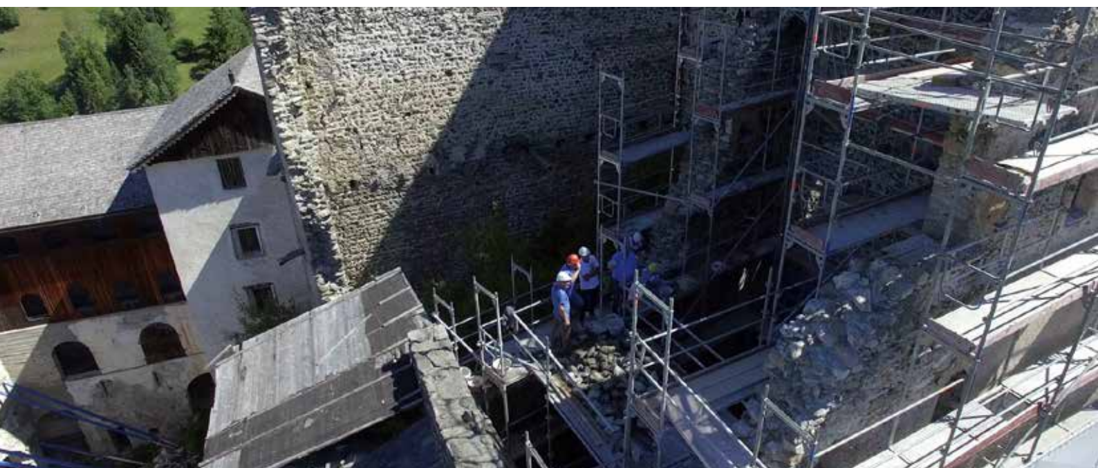
Die Arbeiten an der südlichen Kernburg konnten im Sommer abgeschlossen werden. Die Mauerkronen sind saniert und zusätzlich „vernadelt“. Bis zu drei Meter lange Eisenstäbe sorgen für zusätzliche Stabilität.
