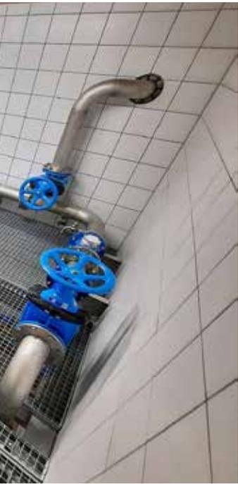
Blick in die Schieberkammer. Durch das Fernwirdsystem werden Zu- und Ablaufdaten dauerhaft registriert und gespeichert. Störfallbenachrichtigungen erfolgen automatisiert.
