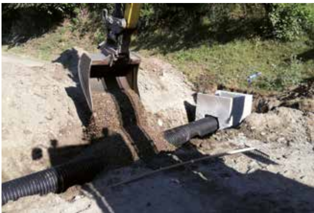
14 Tagwasserquerungen wurden im Zielbergweg verbaut
