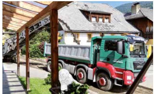
Aushubmaterial wird vom Dorfplatz zum Zielbergweg verführt
