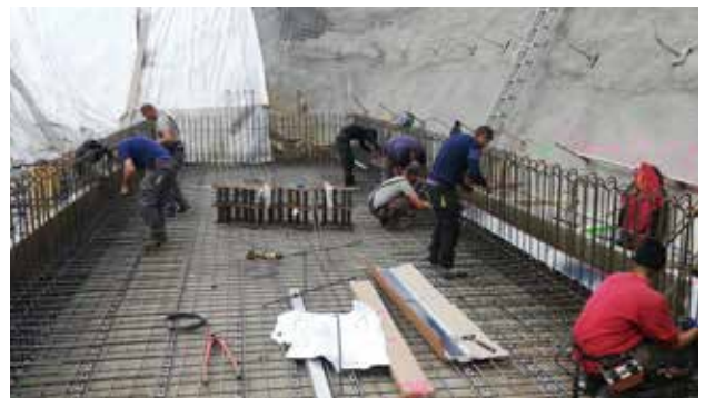
Ausgleichsbeckenerrichtung Kläranlage
