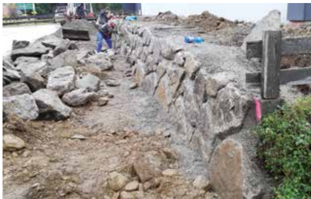
Kreischbergstraße Erweiterung Kreuzung Bahnhof
