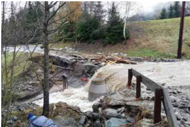
Schwere Unwetterschäden im Bereich Marbach
