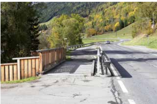
St. Ruprecht Radweg B97 Sanierung Allgaubach
