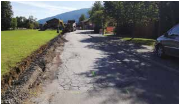
Birkenweg Erweiterung Asphaltplomben
