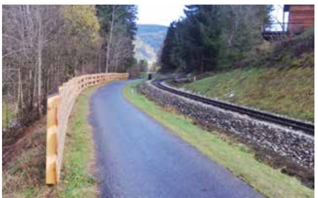
R2 Murradweg Absturzsicherung
