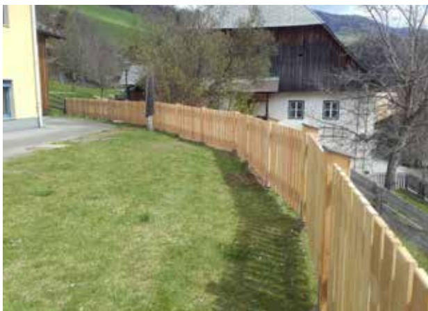
Neuer Holzzaun bei der BienenVolksSchule
