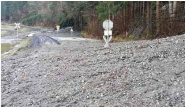
Unwetterschäden am Radweg R2 und der Murtalbahn
