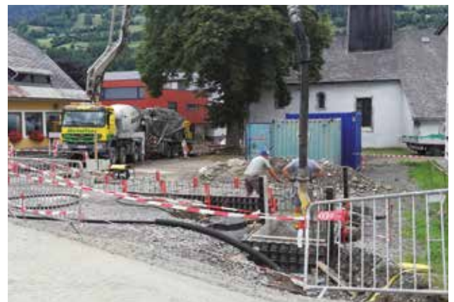
Brunnen betonieren Dorfplatz
