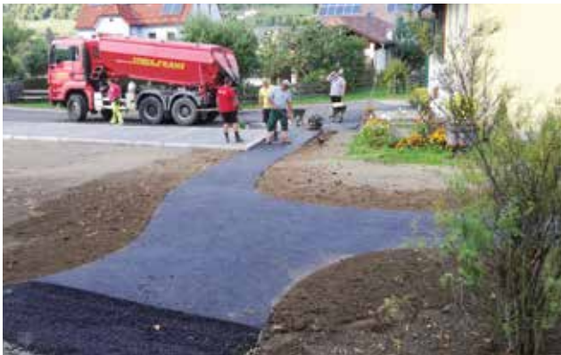
Gehweg asphaltieren – Dorfplatz
