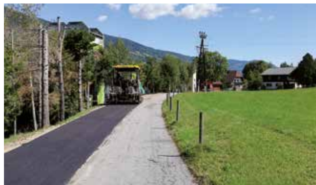
Birkenweg Erweiterung Asphaltplomben
