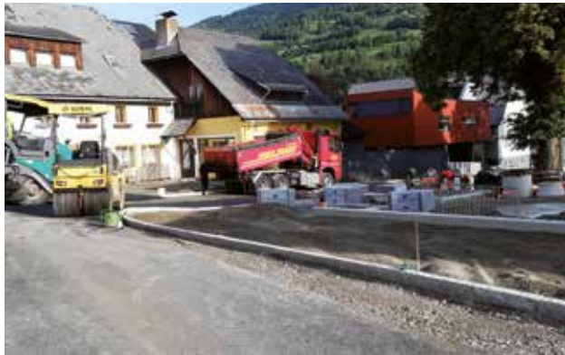
Asphalttragschicht wird eingebaut, Pflasterung der Parkplätze
