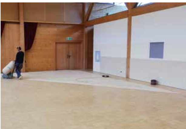
Bodensanierung in der Kreischberghalle
