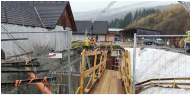
Ausgleichsbeckenerrichtung Kläranlage
