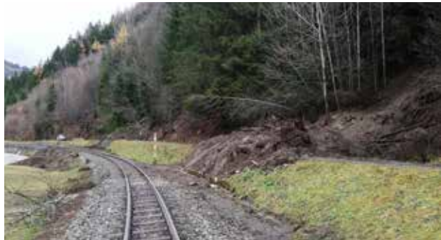
Unwetterschäden am Radweg R2
