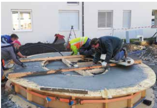
Brunnen wird mit Faserbeton betoniert – Dorfplatz
