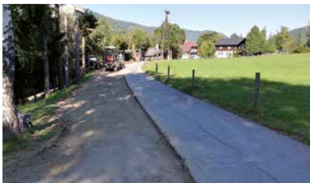
Birkenweg Erweiterung Asphaltplomben
