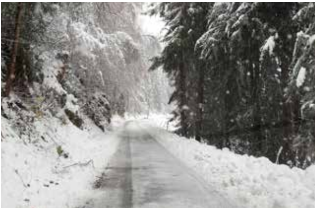
Straßensperre Grabenstraße, Hinterer Kothschildergrabenstraße
