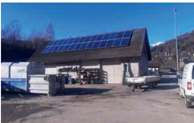
Montage Photovoltaikanlage im Bauhof
