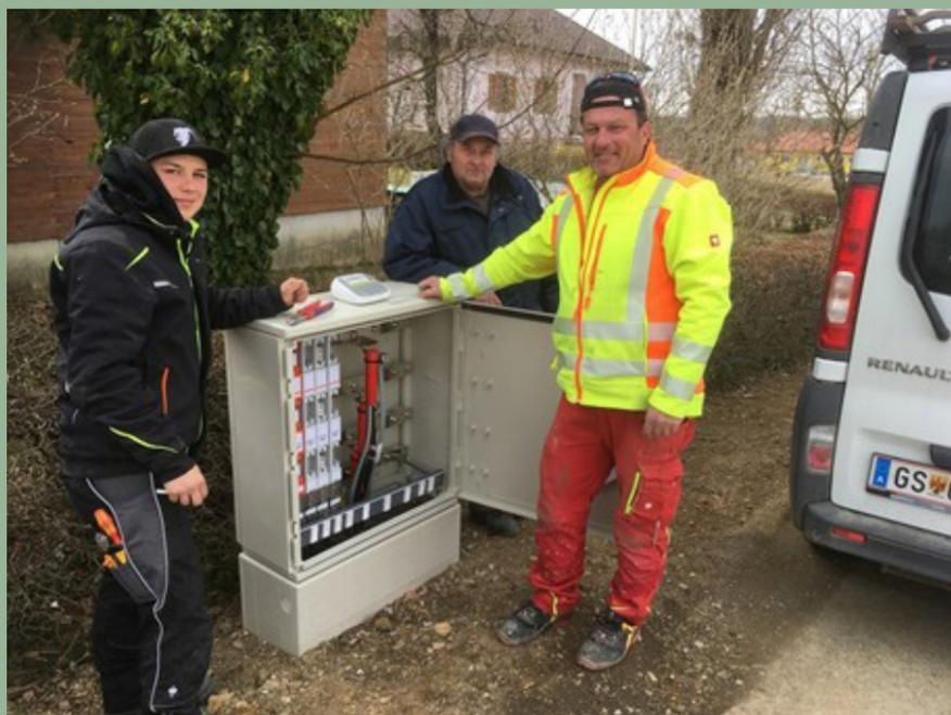
Derzeit werden von Netz-Burgenland in Poppendorf-Berg Kabellegungsarbeiten durchgeführt. Von der bestehenden Trafostation in Richtung Haidenberg und im Kapellenweg wird die Stromversorgung von oberirdisch (Dachständer) auf unterirdische Zuführung geändert. Gleichzeitig werden seitens der Gemeinde auch Telefonkabel mitverlegt, um die Telefonmasten und Luftkabel zu entfernen. Das ergibt ein schöneres Ortsbild und erleichtert die Mäharbeiten am Straßenrand.
