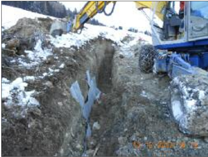
Drainagierung des „Eilerbachs“ im Bereich der Rieserhöfe
