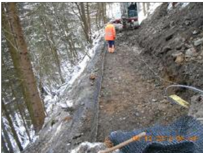
Sanierungsarbeiten beim Kirchsteig in Panzendorf
