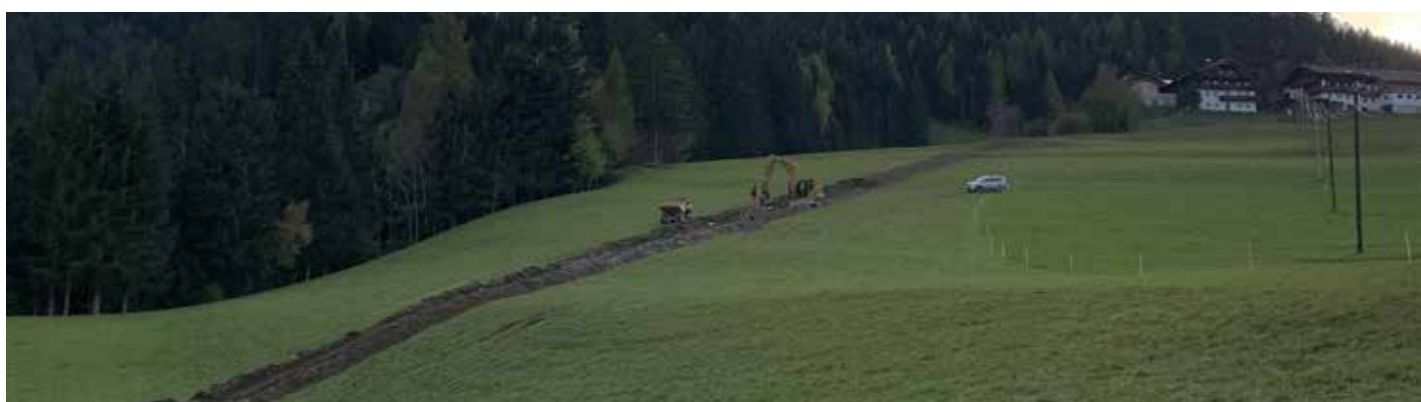
Das Glasfasernetz wird laufend erweitert. Hier die Grabungsarbeiten für die Leitung Richtung Gschwendt.
