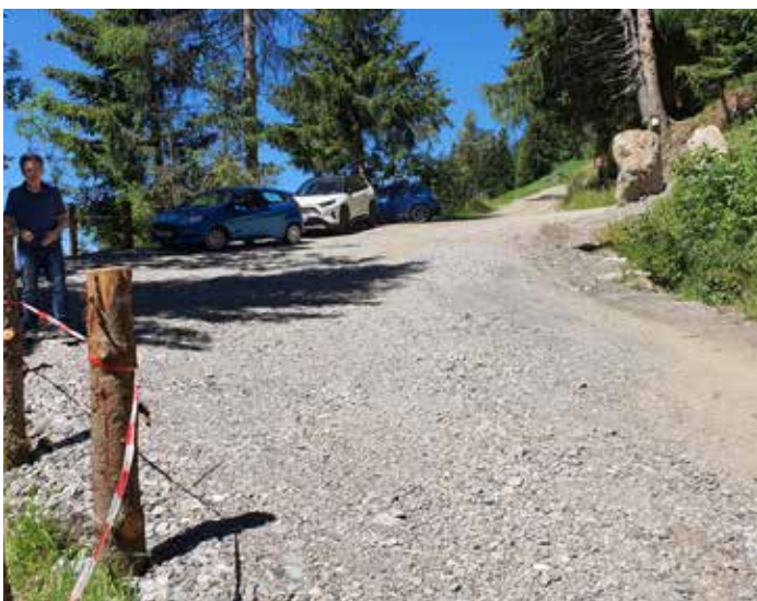
Sanierungsarbeiten Tessenberger Almweg
