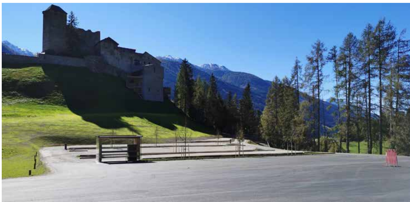
Errichtung des Parkplatzes für die Burg Heinfels
