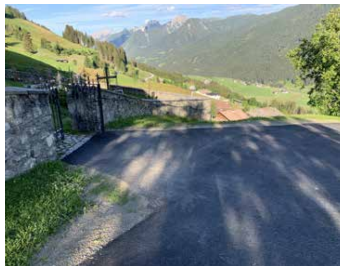
Asphaltierung Zugang zum Friedhof in Tessenberg
