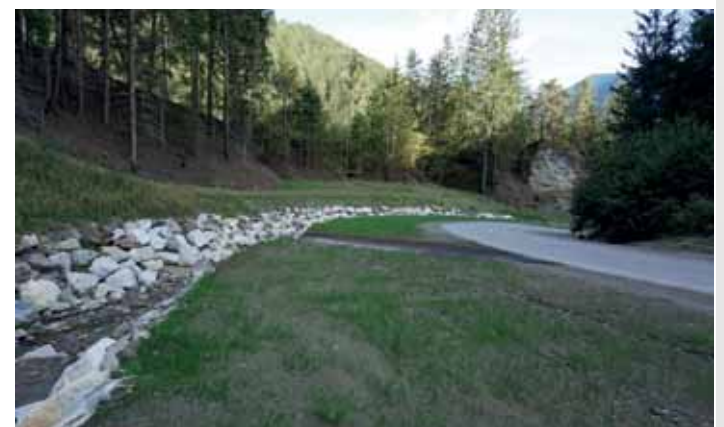
Schmidbognerbach - Ausbau des Gerinnes
