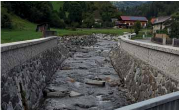
Erhöhung der Ufermauern oberhalb der „Wohleserbrücke“
