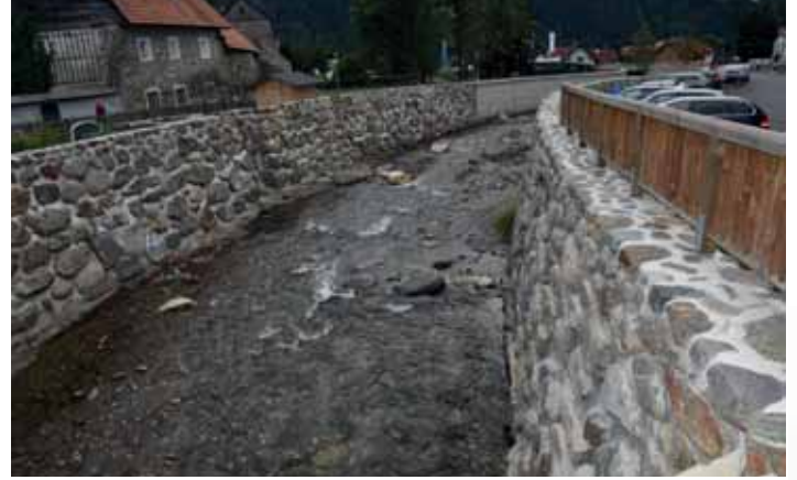
..... und im Bereich unterhalb der Hintereggertorbrücke
