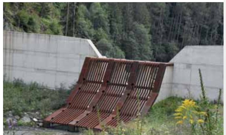
Ein großartiges Bauwerk für die Sicherheit der Stadt Oberwölz: Die neu errichtete Filtersperre am Schöttlbach
