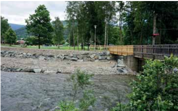
Regulierung des Gerinnes im Bereich Freibad / Hochseilgarten
