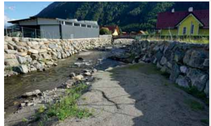
Verbauung im Bereich unterhalb der Landesstraßenbrücke
