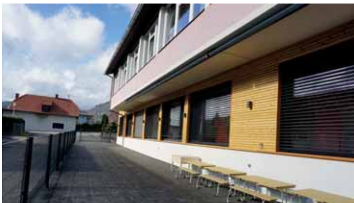
Außenansicht der 4. Kindergartengruppe (ehem. Rüsthaus der Feuerwehr)
