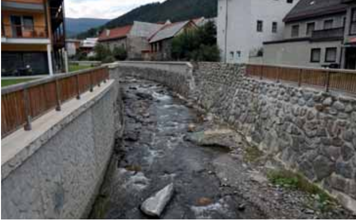
Erhöhung der Ufermauern im Bereich Seniorenwohnheim...
