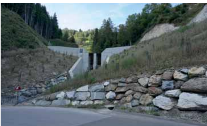
Filtersperre Schmidbognerbach mit einem Fassungsvermögen von rd. 10.000 m 3
