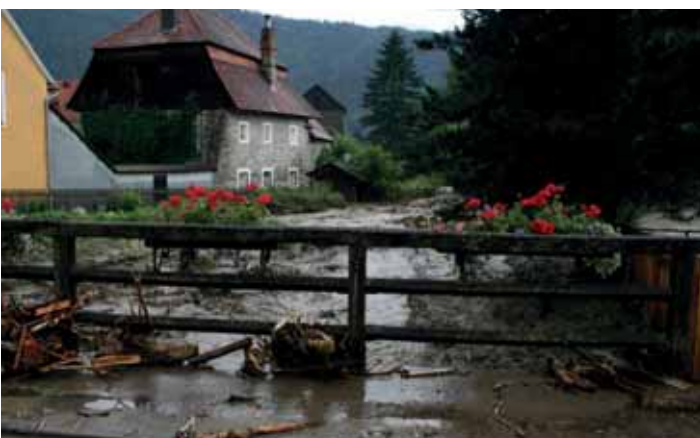
Die Situation bei der Hintereggertorbrücke nach dem Hochwasser vom 7.7.2011 .....
