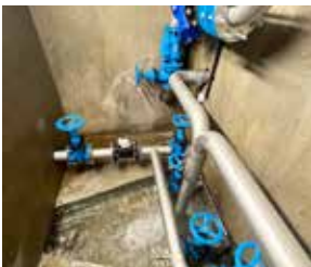
Neue Verrohrung im Untergeschoss
