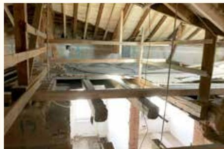
**Auch im Dachboden ist einiges passiert – eine neue Mittelpfette und A-Stützen halten das Dach jetzt wieder viele Jahre. Außerdem wurde auch gleich eine Wärmedämmung eingebracht.**
