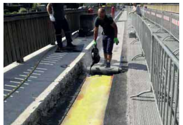
Holzeuropabrücke Abdichtarbeiten
