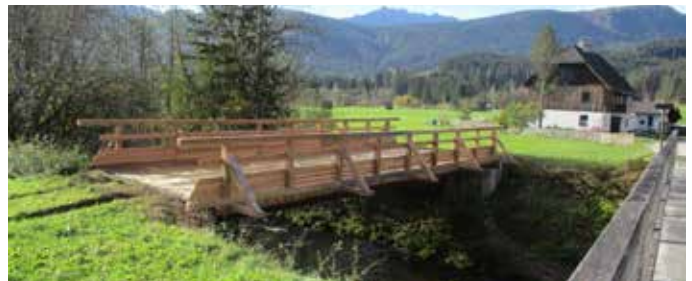
Auch die Loipenbrücken, wie hier über die Salza im Bereich der Kläranlage, wurden saniert.
