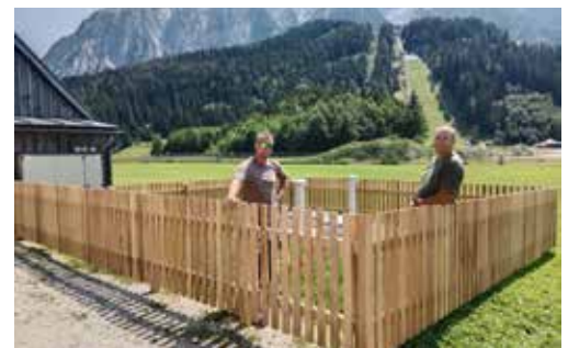
Beim Tiefenbrunnen am Kulm, der die Trinkwasserversorgung von Tauplitz Ort sicherstellt, wurde ein Zaun errichtet.
