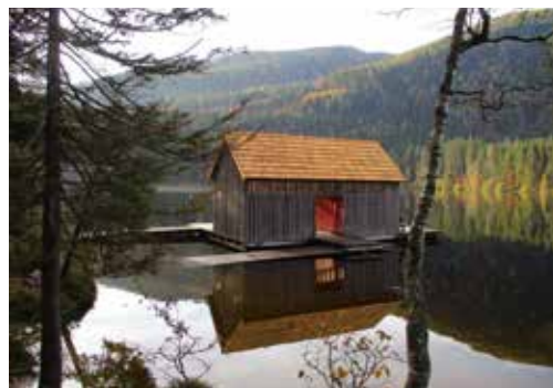
Das Dach der Umkleide am Ödensee erstrahlt in neuem Glanz.
