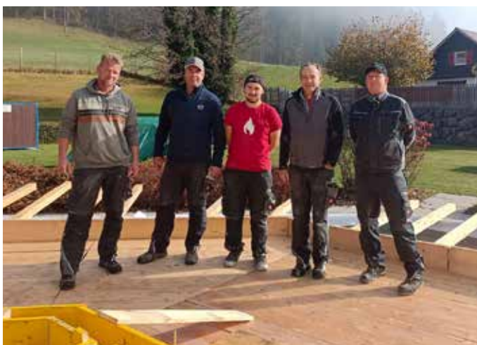
Das Wasserteam hilft tatkräftig beim Abriss und Betonieren im Alpenbad.
