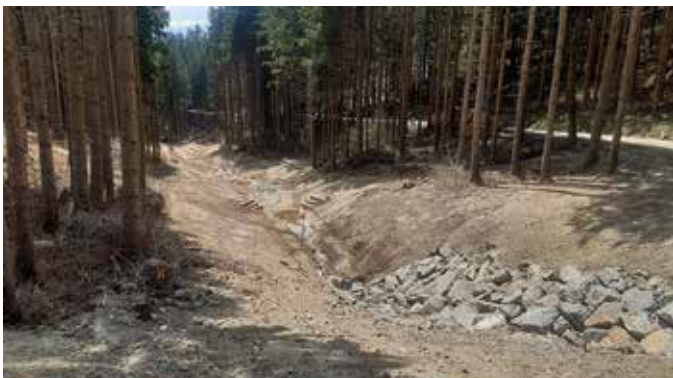
Die baulichen Maßnahmen wurden 2021 fertig gestellt.
