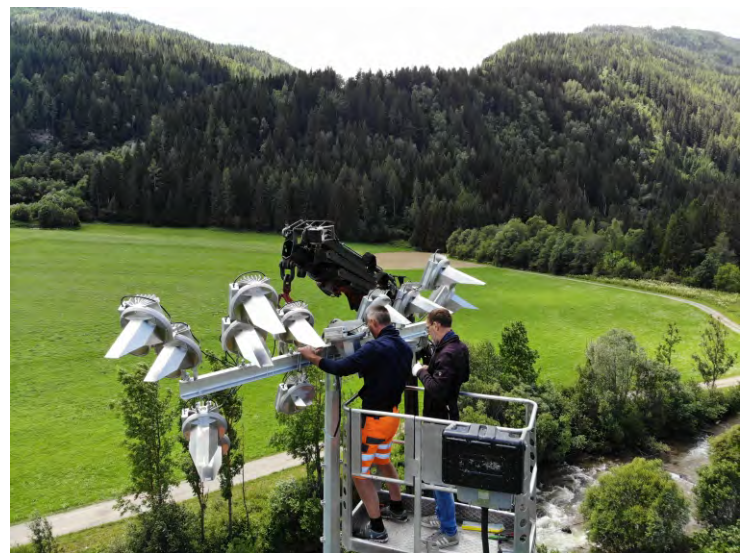
Manfred Lindbichler und Patrick Rauch beim Montieren des neuen Flutlichts.
