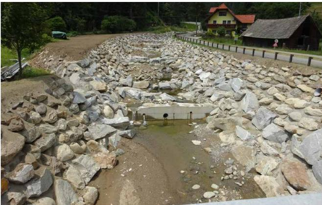
Foto 4: Fertiggestellter Teilabschnitt – Wachenbergbrücke bis hin zur Geschiebesperre
