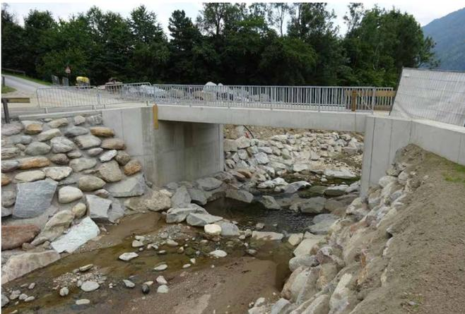
Foto 5: Wachenbergbrücke nach Montage der Absturzsicherung
