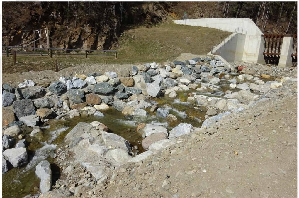
Foto 1: Fertiggestellte Pendelrampe unmittelbar unterhalb der Geschiebesperre
