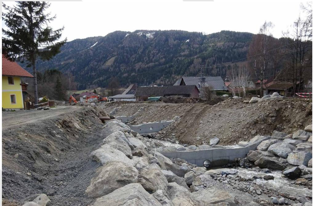
Foto 2: Herstellung von Grundschwelen und Grobsteinschichtungen in Beton
