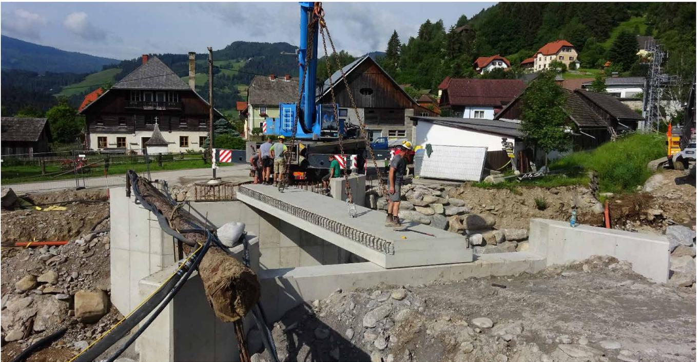
Foto 3: Versetzen der Stahlbetonfertigteile für die neue Wachenbergbrücke
