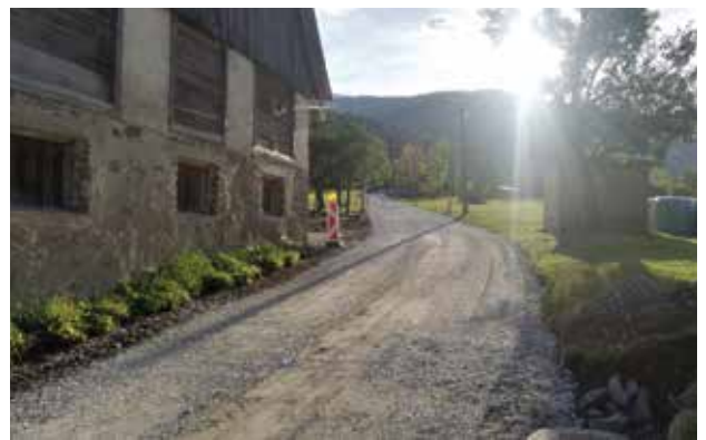
BVH Marbachstraße – Sanierung Richtung Löw
