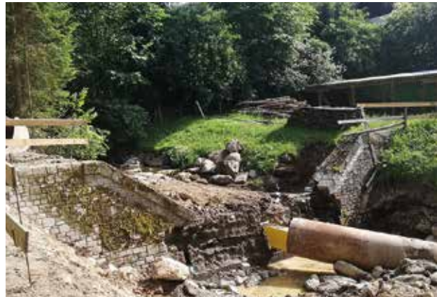
WLV Lorenzbad – Sanierung Bereich vlg. Spreitzer
