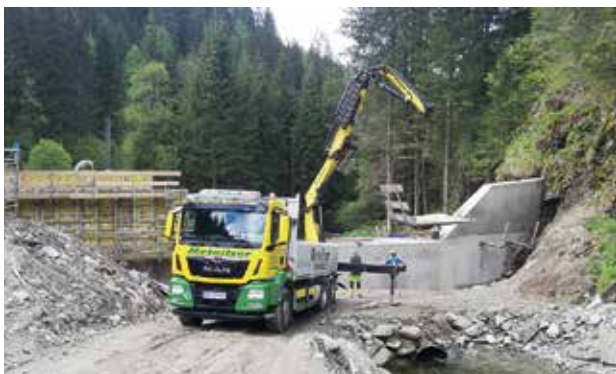
WLV Lorenzbad – Sanierung Leonhardisperre
