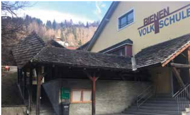
Volksschule St. Ruprecht – Sanierung des Vordaches
