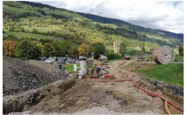
BVH Marbachstraße – Kabelverlegearbeiten
