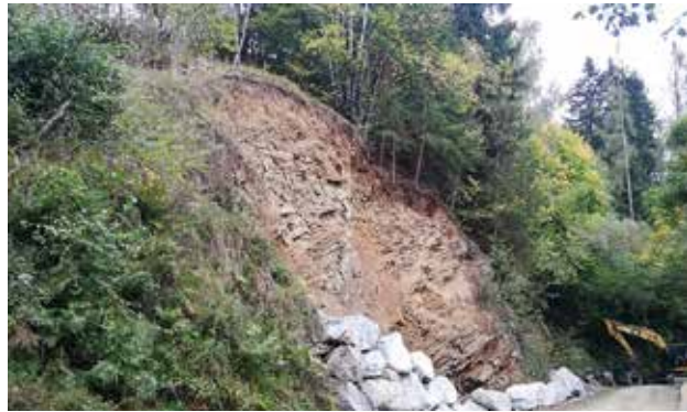
Felssturz Glawischkaweg, Aufbau eines Steinsatzes
