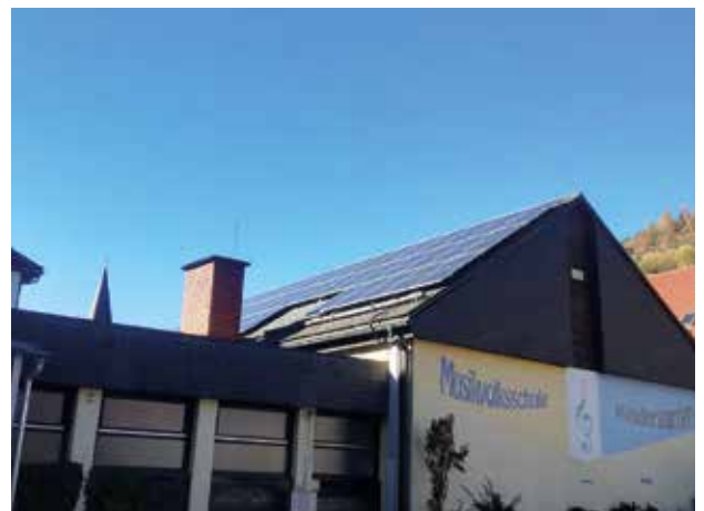
PV-Anlage am Dach der Volksschule St. Georgen PV-Anlage am Dach des Gemeindeamtes
