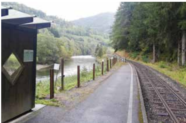
Mursteg St. Ruprecht – Sanierung des Zaunes
