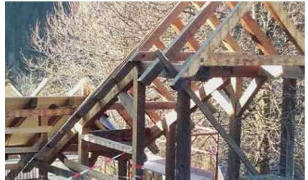
Volksschule St. Ruprecht – Sanierung des Vordaches
