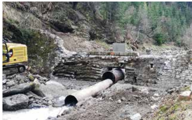
WLV Lorenzbad – Sanierung Leonhardisperre
