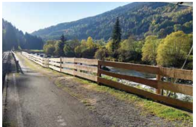
Mursteg St. Ruprecht – Sanierung des Zaunes
