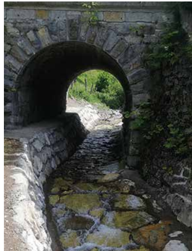
Unwetterschäden Schafferbach – nach fertigem Ausbau
