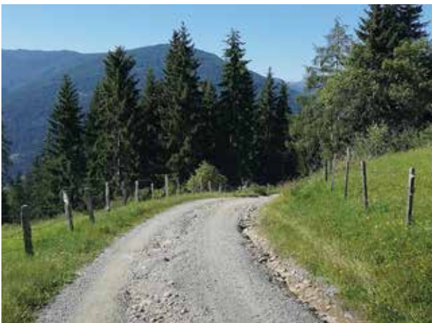
Unwetterschäden Oberes Falkendorf
