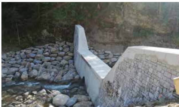
WLV Lorenzbad – Fertig sanierte Leonhardisperre
