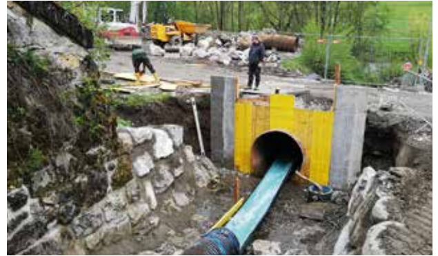
Unwetterschäden Schafferbach – die Querung der Marbachstraße wird erstellt
